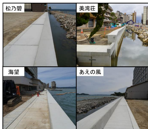
図-5 概成した護岸
