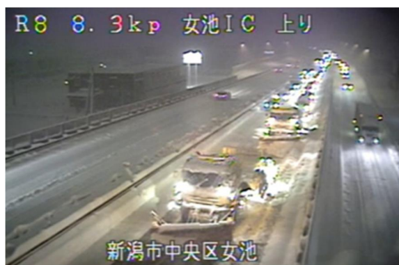
写真-3 通行規制範囲内での集中除雪実施状況
