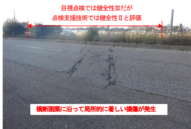
写真-1 コンポジット舗装の損傷状況
