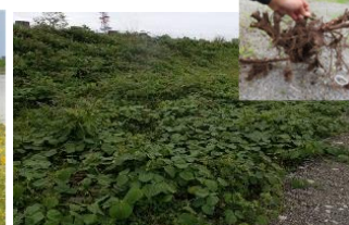
写真-6 クズが密生した堤防 （写真上はクズの主根）
