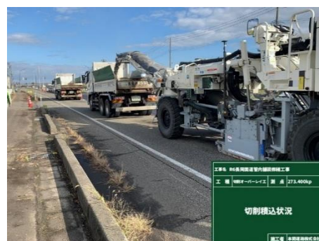
図-9 ホイール式路面切削機による切削オーバーレイ状況
