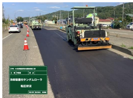
図-10 冷却装置付きタンデムローラによる転圧状況
