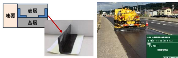
図-8 L型成形目地材(左)とスーパータックゾール(右)
