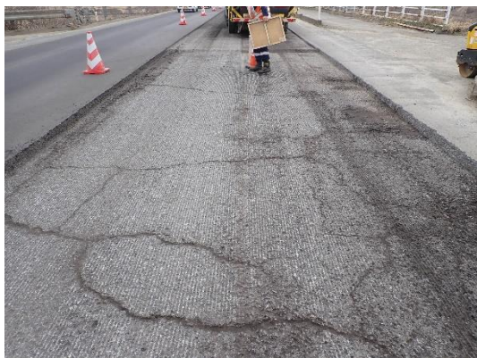
写真3 基層部切削後の残存ひび割れ状況
