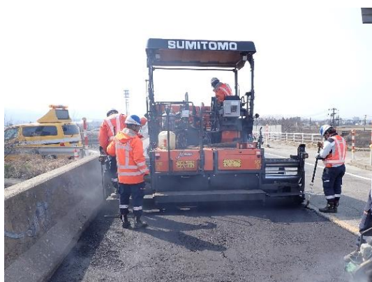
写真4 特殊混合物施工状況
