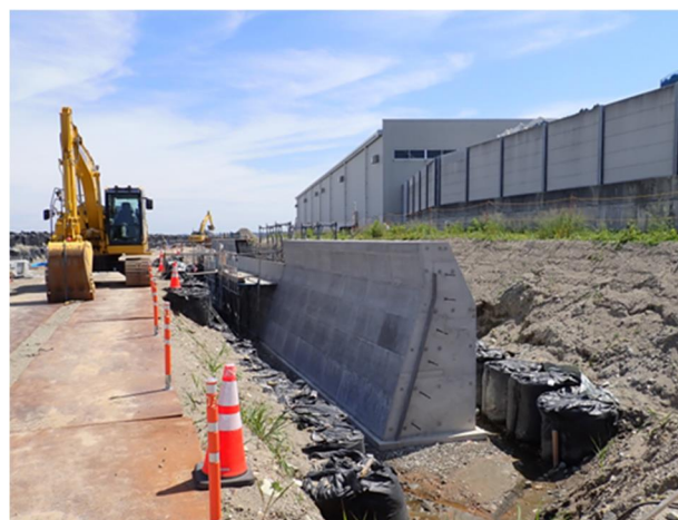
図-9 本復旧工事 波返工施工状況（上戸地区）
