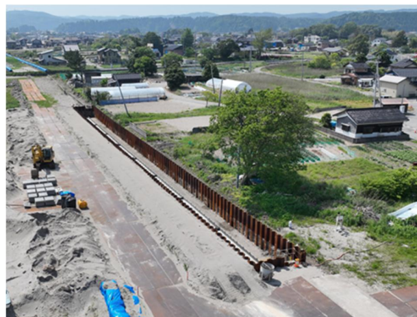
図-8 本復旧工事 波返工施工状況（正院地区）
