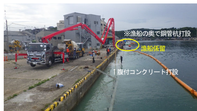
図-11 漁船が係留できる延長を確保しながらの施工
