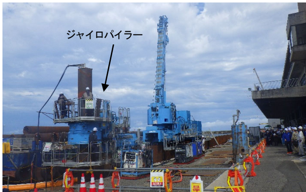
図-10 ジャイロプレス工法による鋼管杭圧入
