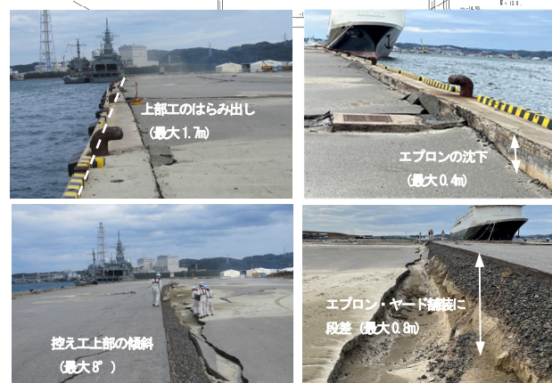
図-5 物専岸壁の被災状況
