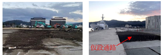
図-2 港湾関連用地からの路盤材の掘り起こし(左)、それを活用した岸壁背後の応急復旧(右)
