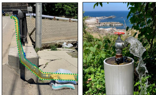
写真-6 仮設配管敷設、仮通水状況
