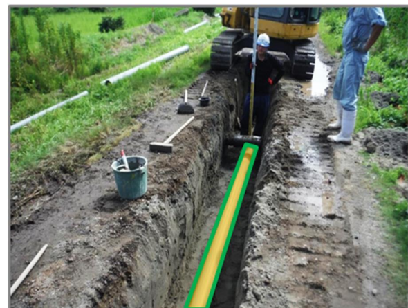
写真-2 仮設管渠の設置
