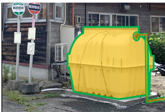
写真-3 仮設浄化槽の設置
