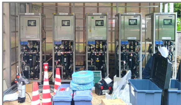
写真-5 可搬型浄水装置の設置
