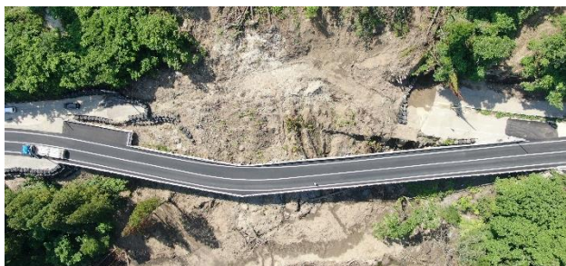
写真-12 応急復旧の仮橋の写真
