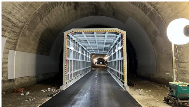
写真-10 トンネル内にプロテクターを設置した写真
