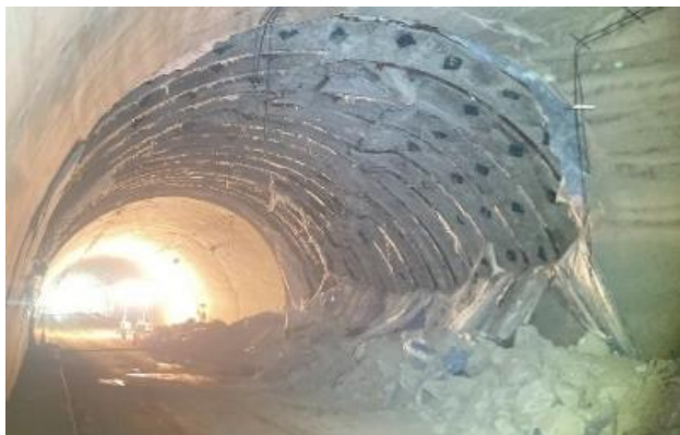
写真-8 トンネル内の被災した箇所写真
