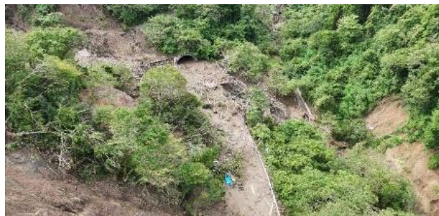
写真-11 豪雨後トンネル内に土砂が流入した写真
