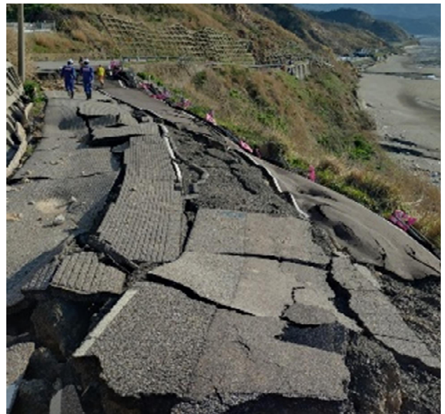
写真-6 地震により舗装が破損した大川浜工区の写真
