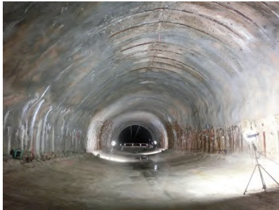
写真-3 一次内空断面補強
