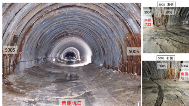
写真-2 インバート変状発生状況(S005～S006)
