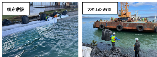
図-3 応急復旧工事の施工状況
