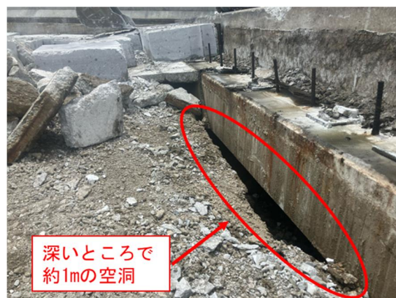
写真-3 路盤沈下状況
