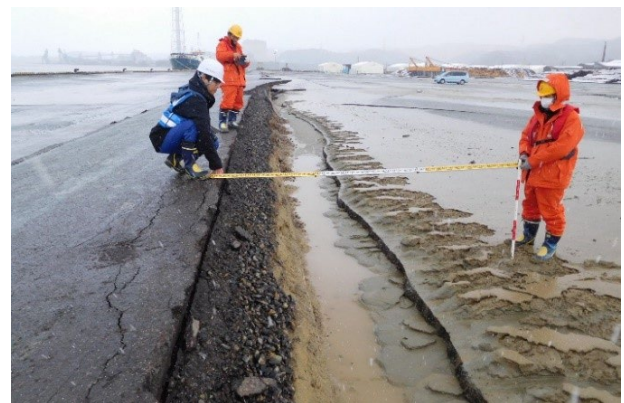
図-3 控え上部工背後で発生した段差
