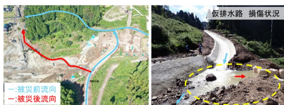
図-13 仮排水路の被災状況（輪島市市ノ瀬町）
