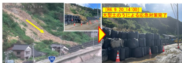
図-8 土砂流出による大型土のう倒壊（珠洲市清水町）
