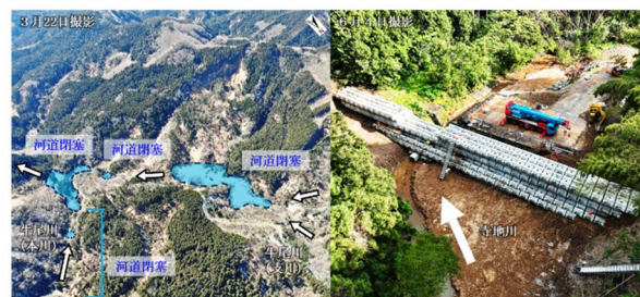
図-5 土砂流出に備えたブロック堰堤による応急対策（輪島市町野町牛尾）
