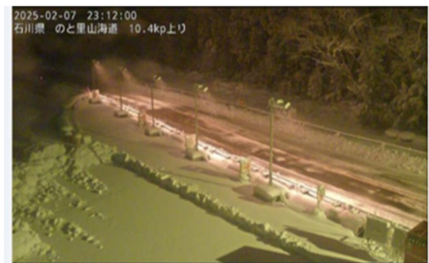
写真-4 のと里山海道（横田IC）赤外線融雪装置
