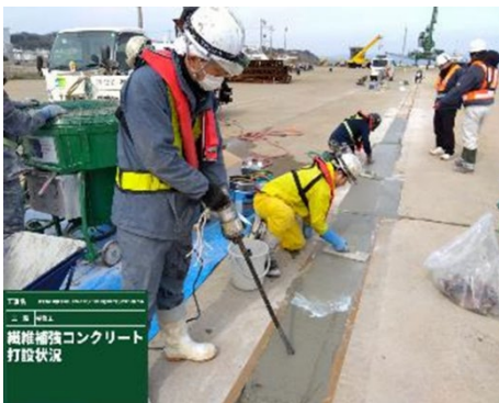
図-9 補修工（断面修復）
