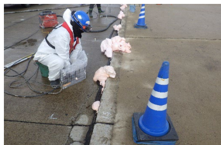
図-6 注入工法（ウレタン注入状況）
