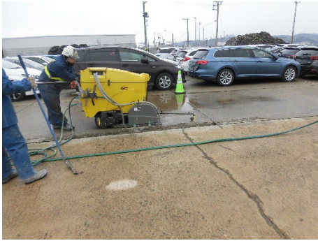
図-7 補修工（舗装版切断）
