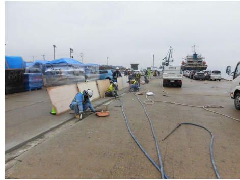
図-11 合板による養生状況
