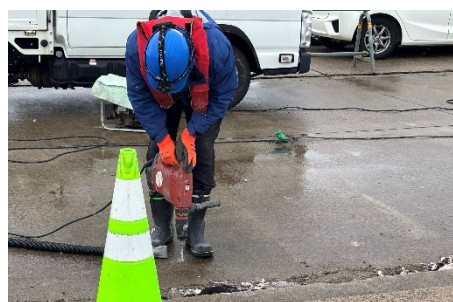
図-5 注入工法（削孔）
