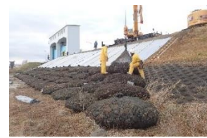
写真-4 袋詰め玉石据付状況
