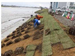
写真-9 植生工施工状況
