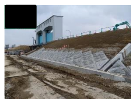
写真-8 高水護岸施工状況
