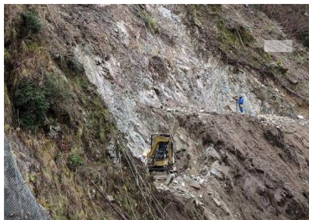
写真-2 ロッククライミングバックホウでの施工
