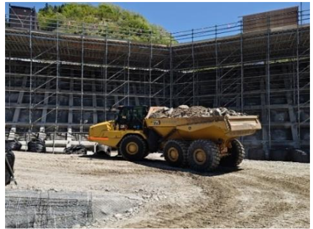
写真-9 アーティキュレートダンプによる排土
