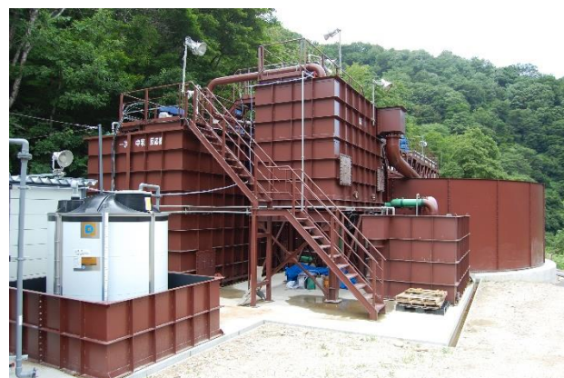
写真-7 濁水処理設備の施工状況（R7.6末）
