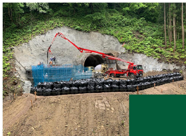
写真-3 置き換えコンクリート施工
