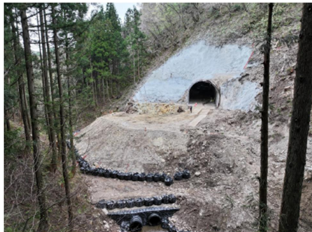
写真-2 先進導坑貫通
