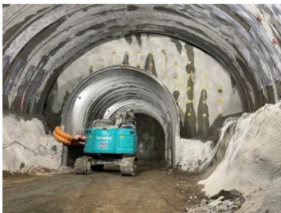
写真-1 先進導坑掘削
