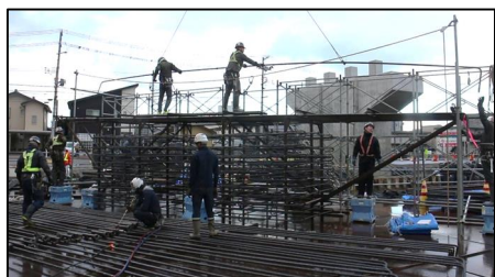
写真3 鉄筋組立施工状況
