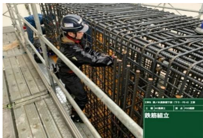
写真-1 高所での鉄筋組立状況
