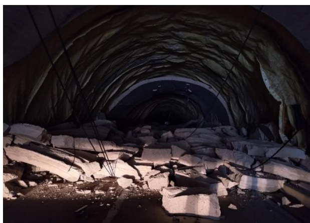
写真4 崩落した大谷トンネルの覆工コンクリート
