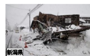
写真-9 空き家積雪による倒壊
