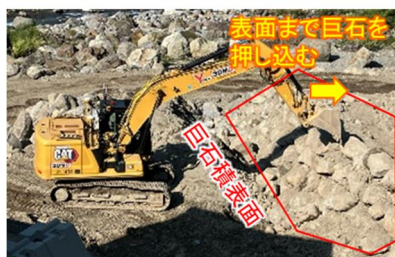
図-9 巨石積（空）設置状況
