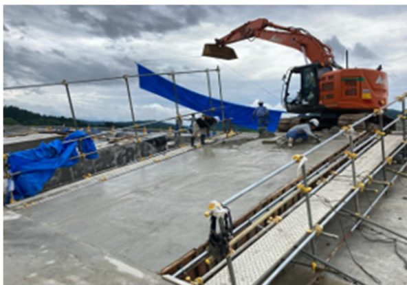
写真- 5 養生シート設置中の様子
