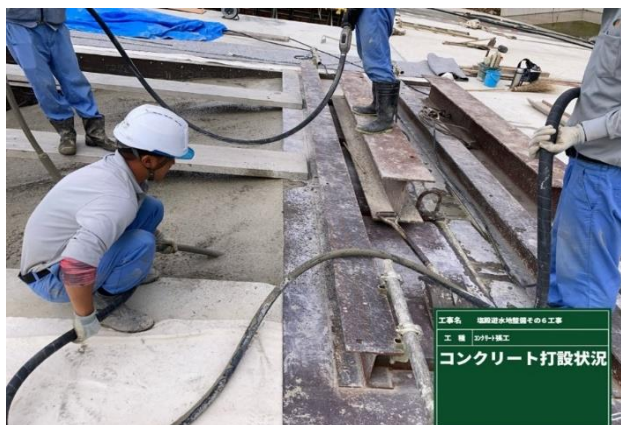
写真- 2 コンクリート締め固めの様子
