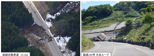
写真-1 被災状況（左：能越自動車道、右：国道249号）
