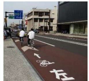
図-2 自転車走行帯の設置
