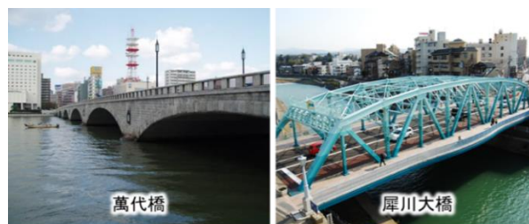
写真-2 北陸管内における橋梁の長寿命化の好事例
