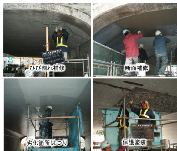
写真-3 萬代橋における予防保全型メンテナンス実施事例
