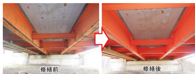
写真-1 須沢放水路橋における予防保全型のメンテナンス事例
