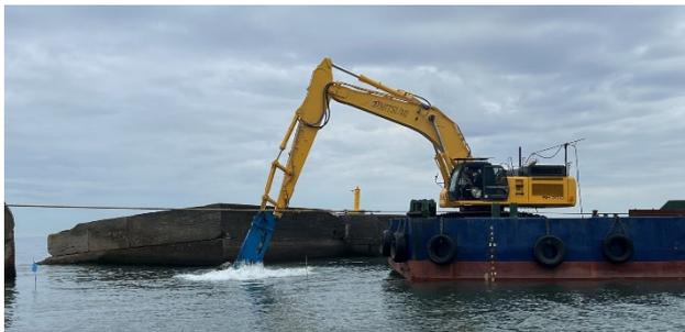
写真-4 コンクリート一次破碎状況
