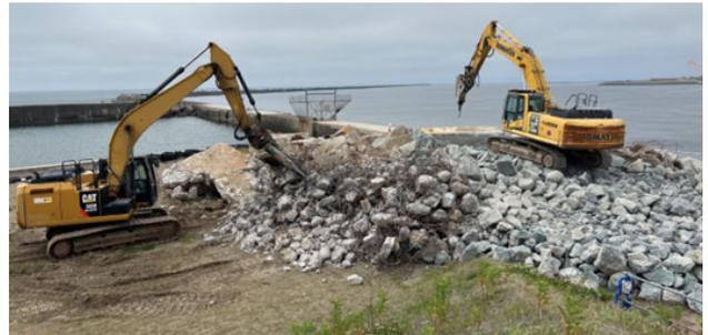
写真-5 コンクリート二次破碎状況
