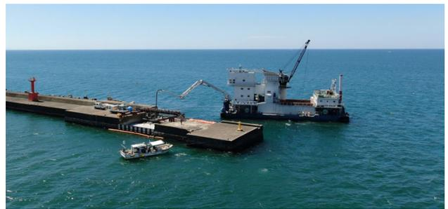
写真-6 コンクリートミキサー船での打設状況
