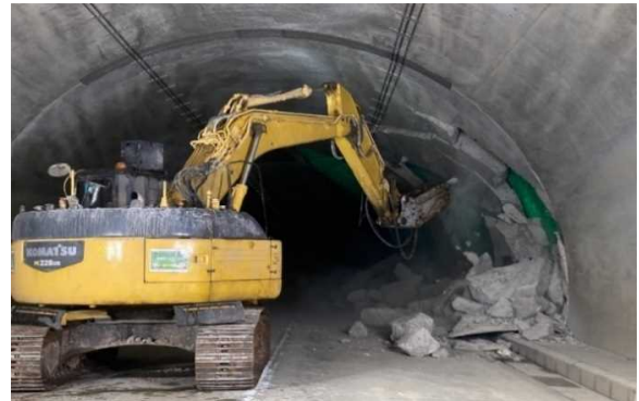
写真－4 既設の覆工撤去
