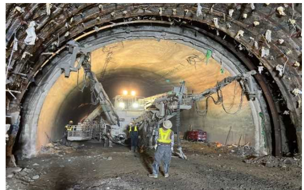
写真－6 縫返し（支保工の再設置）
