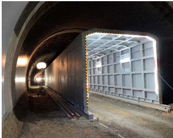
写真-7 プロテクター設置・場内整備
