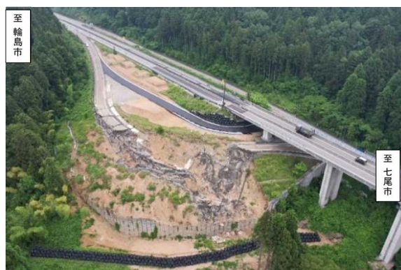
図-10 穴水 IC における応急復旧完了状況
