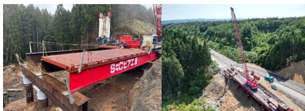
図-7 穴水道路 14.1kp における応急復旧状況
