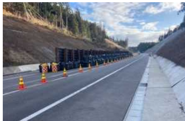
図-12 対面通行確保状況（石川県輪島市三井町中地先）
