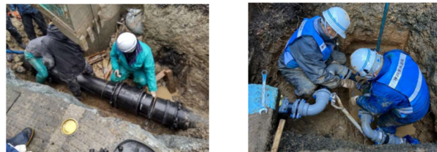
写真-1 復旧作業の状況 4)
