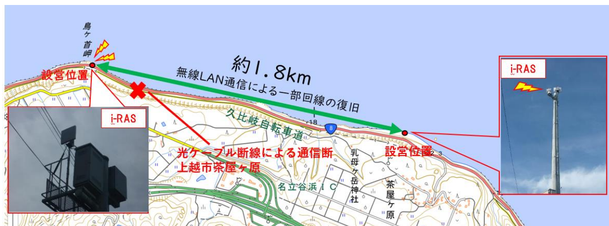
図-13 i-RAS 設置状況
