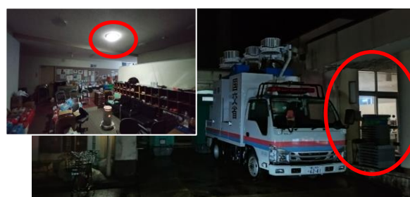
電源供給により停電を解消（珠洲市 日本小学校）
