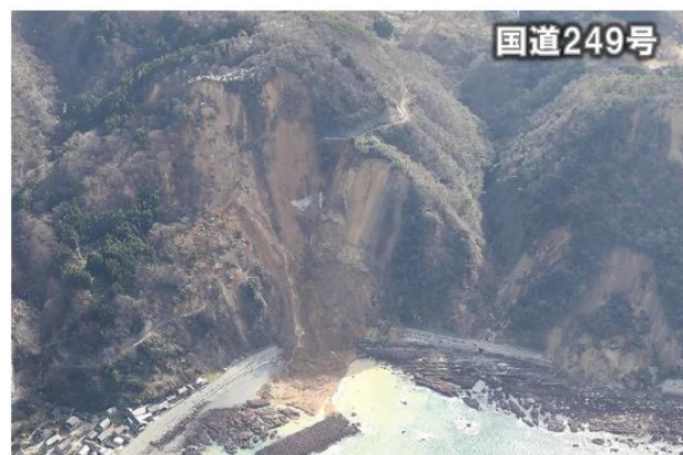
図-5 ヘリサットからの国道 249 号土砂崩壊映像
