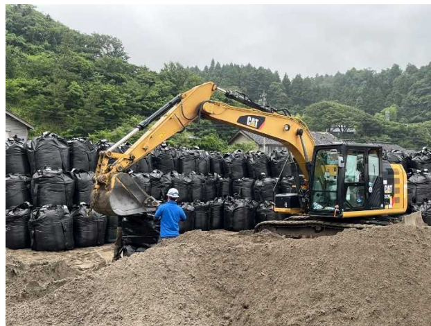
写真-1 大型土のう作成状況
