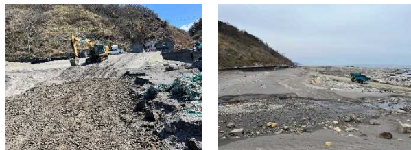
写真-2 工事用進入路作成状況
