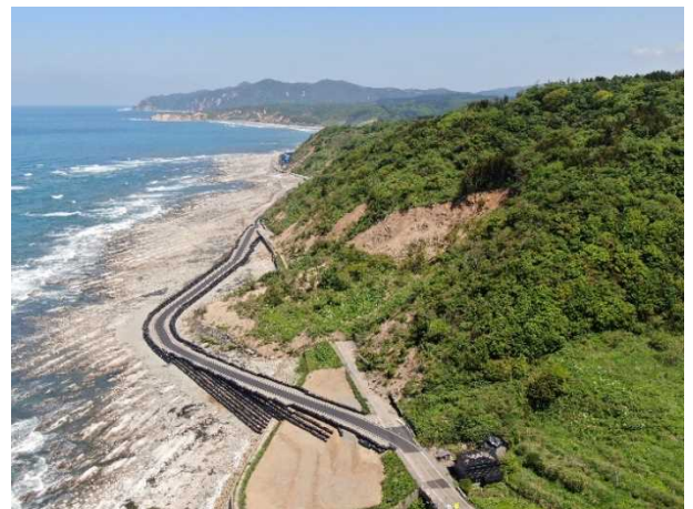
写真-6 I 期線交通開放後の千枚田工区
