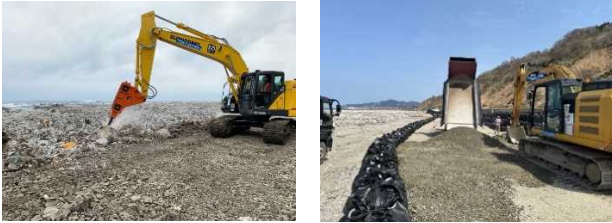
写真-3 路床整正・路盤造成状況
