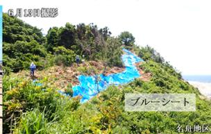
図10 亀裂への浸透防止
