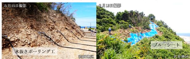
図9 崩落土砂中の水抜き
