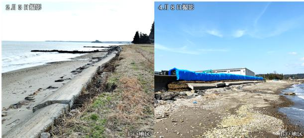
図11 海岸護岸の倒壊状況 図12 仮締切の完了
