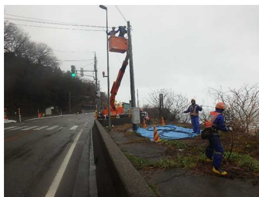
写真-7 i-RAS接続ケーブル配線
