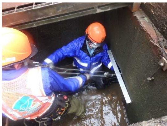
写真-9 光ケーブル応急復旧作業
