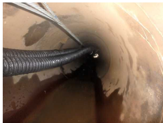
写真-8 排水構内ケーブル配管
