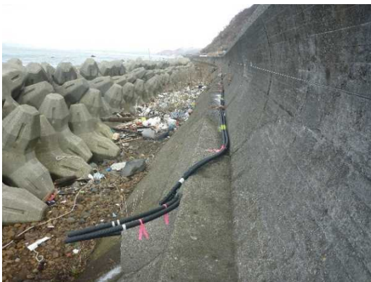
写真-10 護岸擁壁配管
