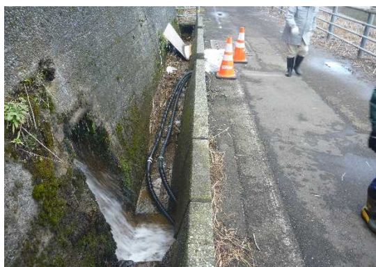
写真-11 自転車道配管
