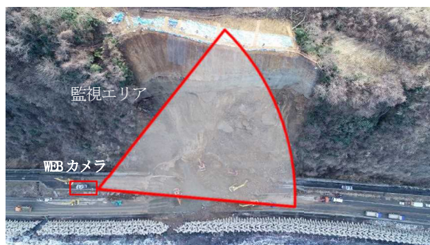
写真-4 土砂撤去工事の状況写真
