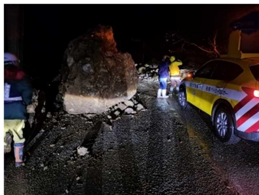
図-8 道路啓開前に先行調査で復旧方針を確認する様子(石川県輪島市三井町本江)
