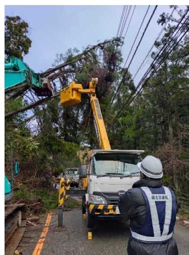
図-9 電線管理者による立木切断電力送配電(株)へ立
