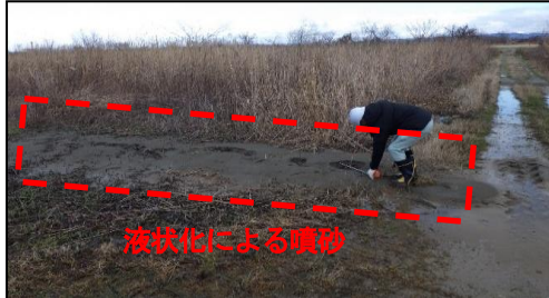
写真⑨ 堤防法尻付近の高水敷上の噴砂
