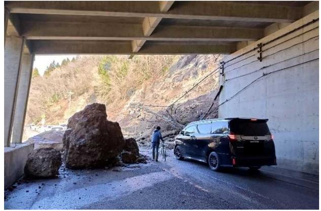
写真-3 道路の被災状況 (輪島市 落石)
