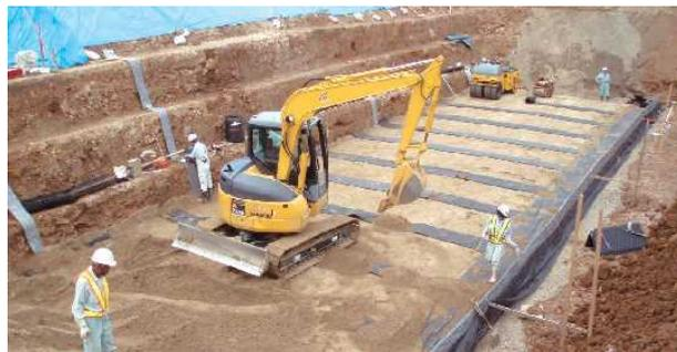
写真5 水平排水材の敷設状況<sup>2)</sup>
