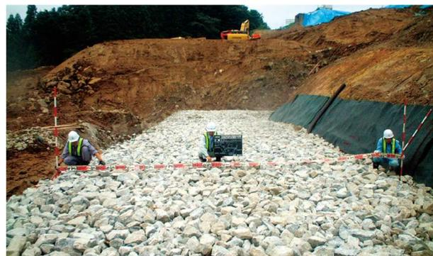
写真6 栗石による基礎置換<sup>2)</sup>
