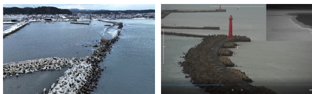
写真-3 ドローンによる被害調査(左:飯田港, 右:新潟西港)
