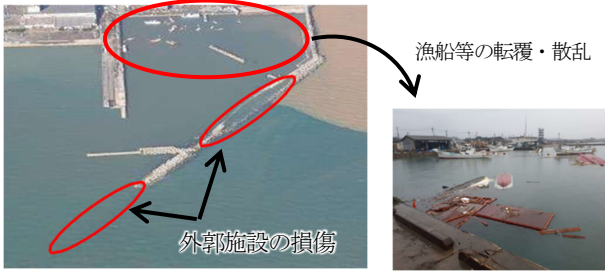
写真-1 津波による被害(飯田港(珠洲市))
