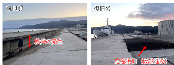
工事における臨機の対応として、当時、材料や機材等
