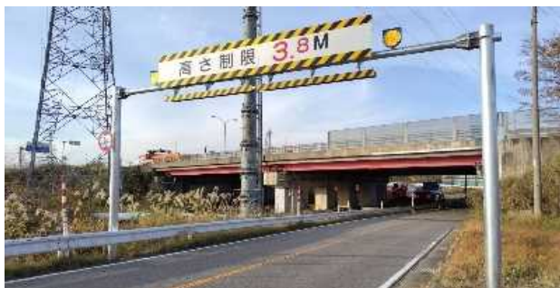
図 5 損傷復旧前後の写真
