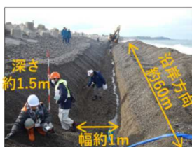
図-3 トレンチ掘削の概要
