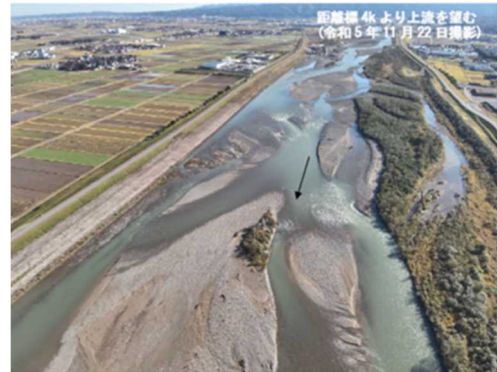
写真-2 手取川空中写真（距離標4kより上流を望む）
