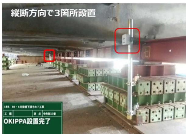
写真-8 『OKIPPA』の設置状況
