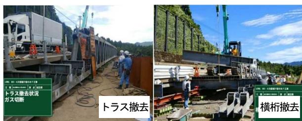
写真-6 応急組立橋の撤去状況
