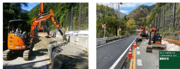
写真-7 小旋回タイプのバックホウによる施工
