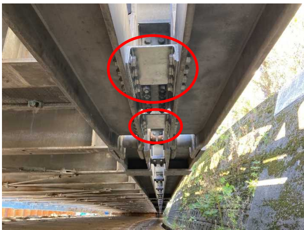
写真-5 トラス主構ガセットの補強
