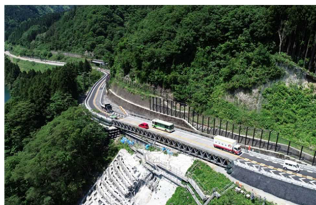
写真-2 応急組立橋による交通開放状況
