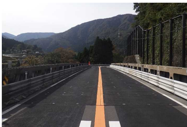
写真-3 凍結抑制舗装の実施状況
