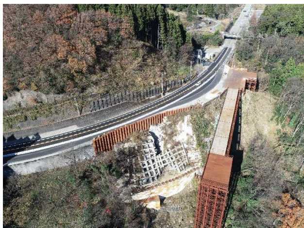
写真-9 応急組立橋撤去後の交通解放状況
