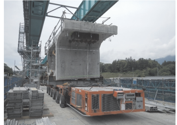
写真-9 多軸台車での運搬
