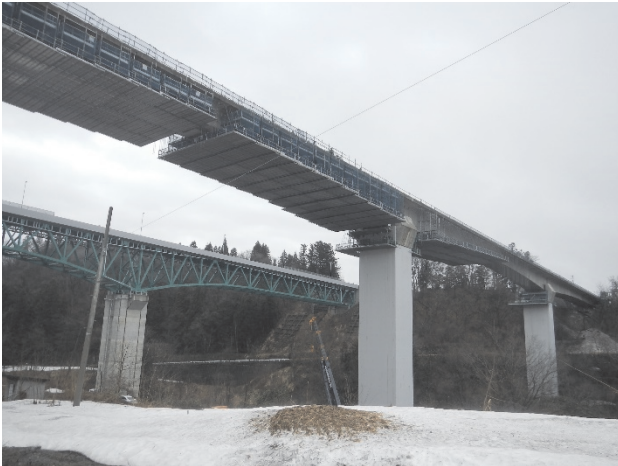
写真-4 吊り足場の設置
