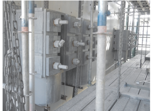
写真-5 仮固定ブラケットの設置
