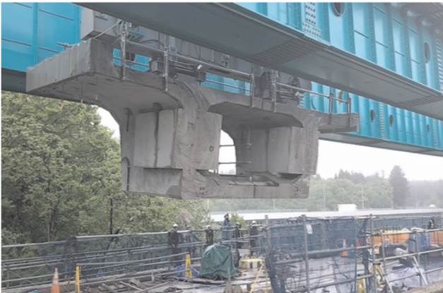
写真-7 吊り装置による運搬
