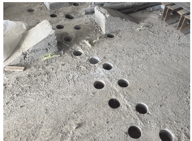
写真-6 コア穿孔後の様子
