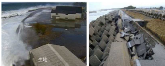
写真-1 過去の被災状況
