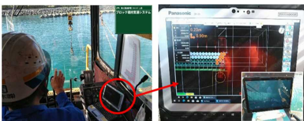
写真-5 ブロック支援システム
