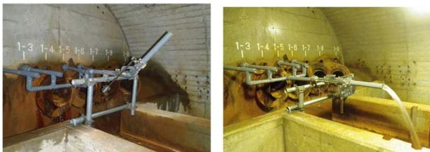
写真-2 集水管閉塞防止器の設置状況
