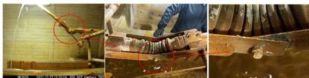
飛散した水しぶきや排水管から流下した水により、可動部に石灰分が大量に付着している。
