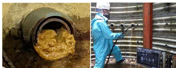
写真-1 沈殿物による集水管の目詰まり状況及び洗浄による付着物の除去作業状況
